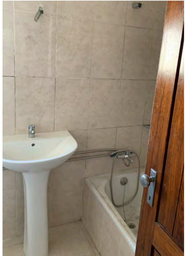
Depois da execução das obras de recuperação
