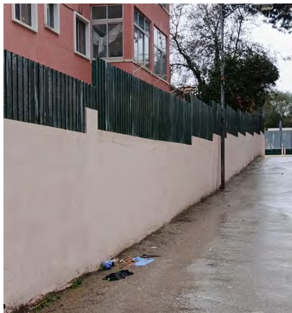
Depois da execução das obras de recuperação
