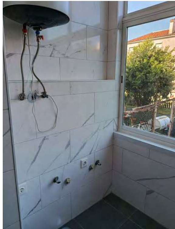
Depois da execução das obras de recuperação
