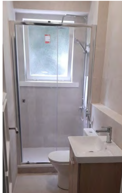
Depois da execução das obras de recuperação
