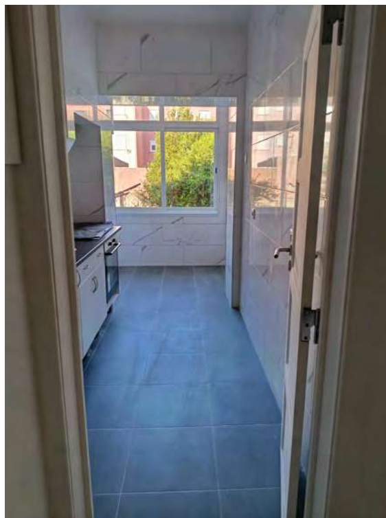
Depois da execução das obras de recuperação
