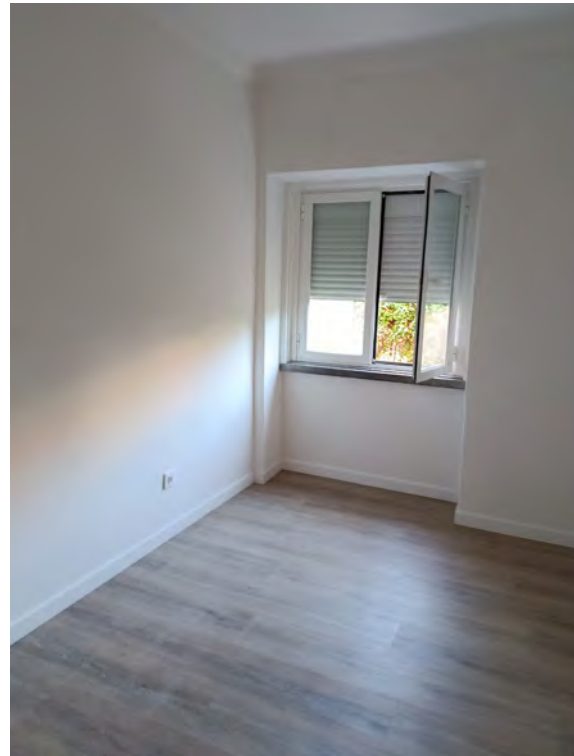
Depois da execução das obras de recuperação
