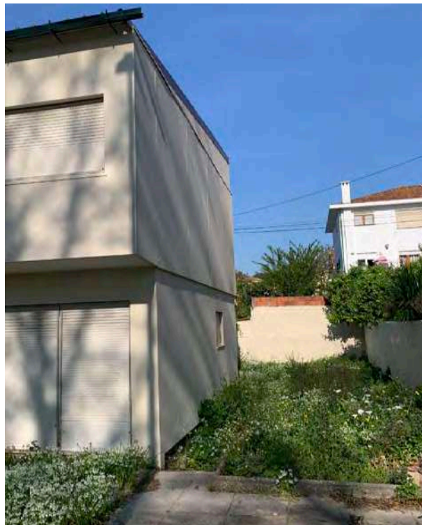
Depois da execução das obras de recuperação
