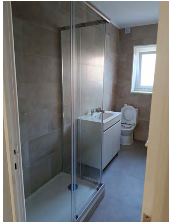
Depois da execução das obras de recuperação
