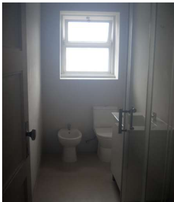
Depois da execução das obras de recuperação
