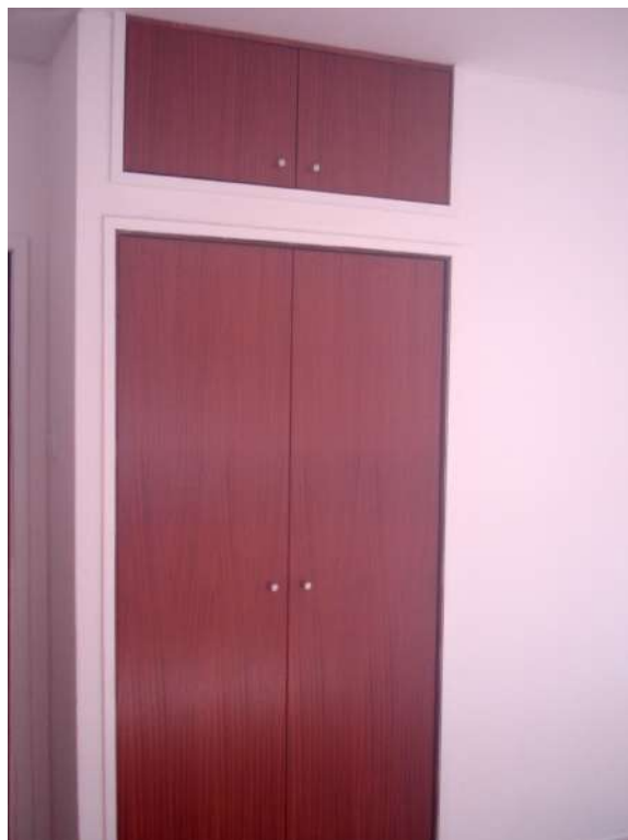
Depois da execução das obras de recuperação
