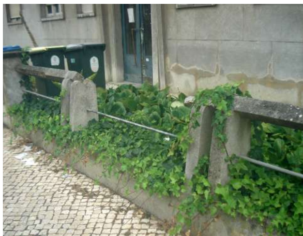
Antes dos trabalhos de reparação
