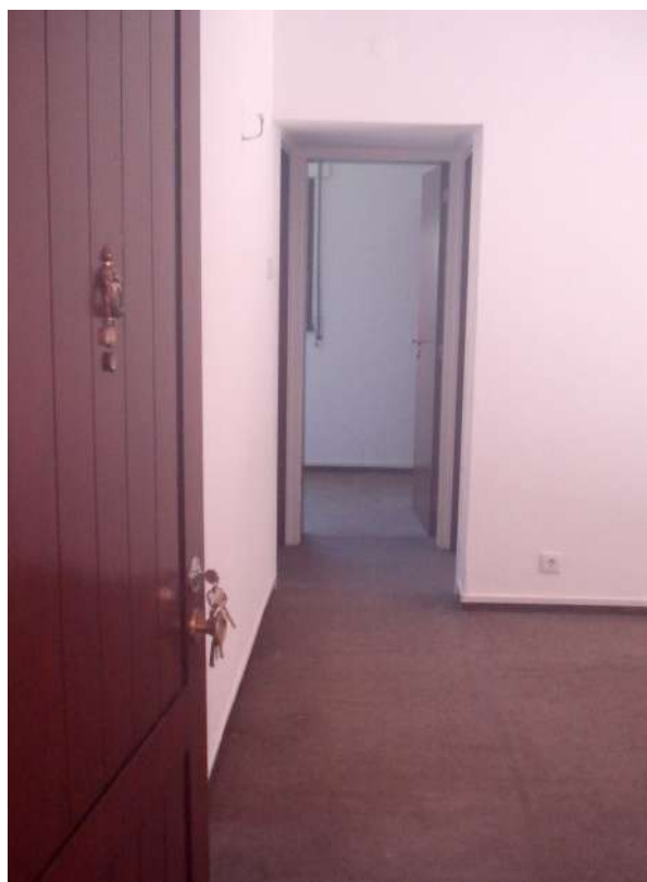
Depois da execução das obras de recuperação
