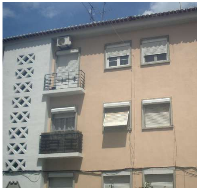
Depois da execução das obras de recuperação
