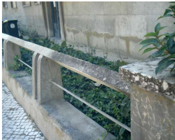
Depois dos trabalhos de reparação
