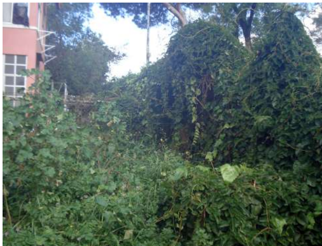
Antes dos trabalhos de limpeza
