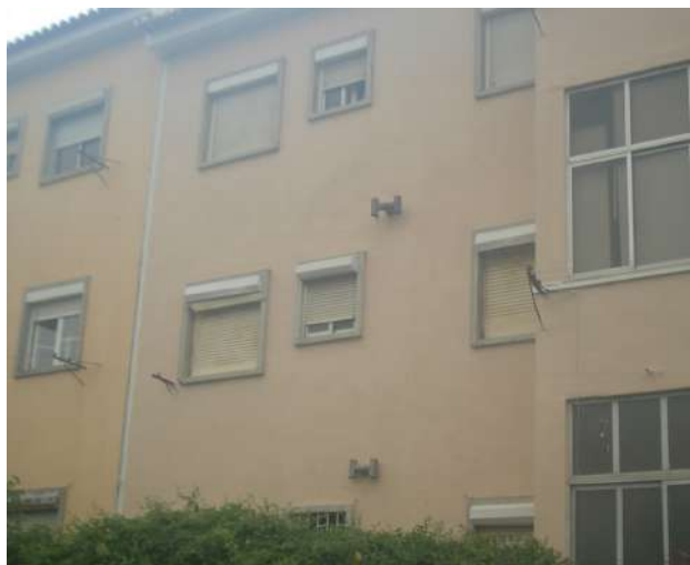
Depois da execução das obras de recuperação
