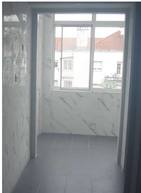
Depois da execução das obras de recuperação
