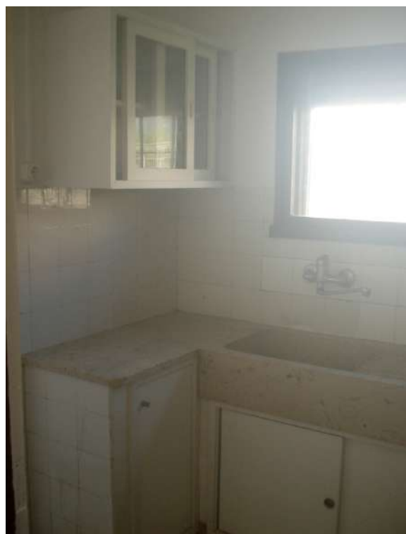
Depois da execução das obras de recuperação
