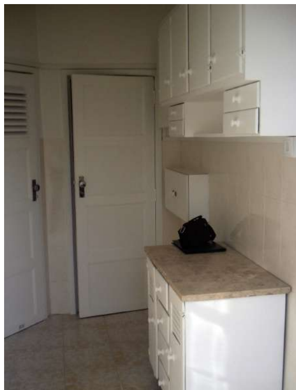
Depois da execução das obras de recuperação
